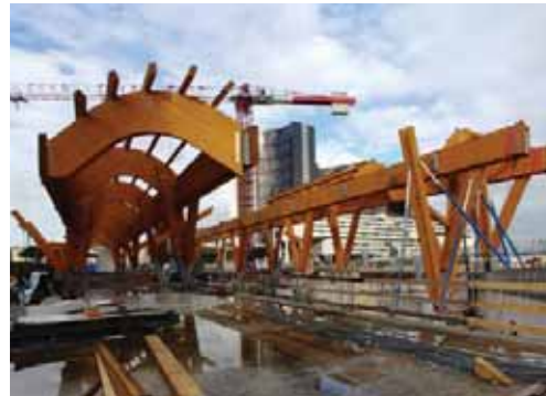
مترو ستيشن - زرقية (محطة وجسر تحت الإنشاء)
